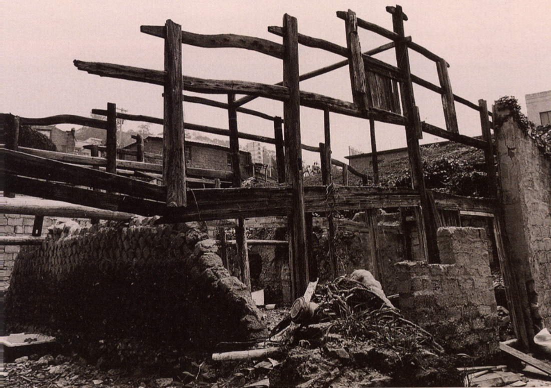
馬祖南竿某民宅廢墟
